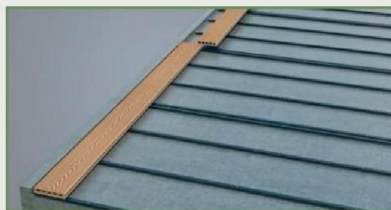
8. เรียงแผ่นไม้พื้น โดยให้ขอบเซาะร่องด้านข้างแผ่นไม้พื้นเข้าล็อกกับคลิป
