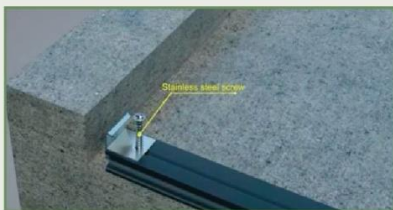
7. ติดตั้งคลิป Starter บริเวณขอบหัวโครงตรงทุกแผ่นตลอดระยะ
